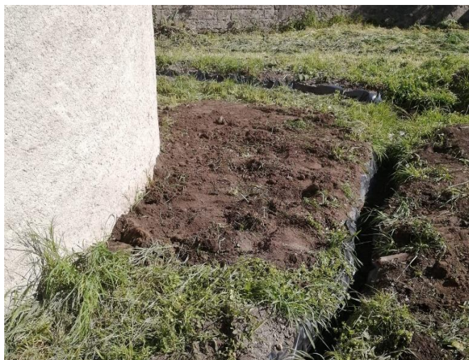
Figure 7 - Remise en état
